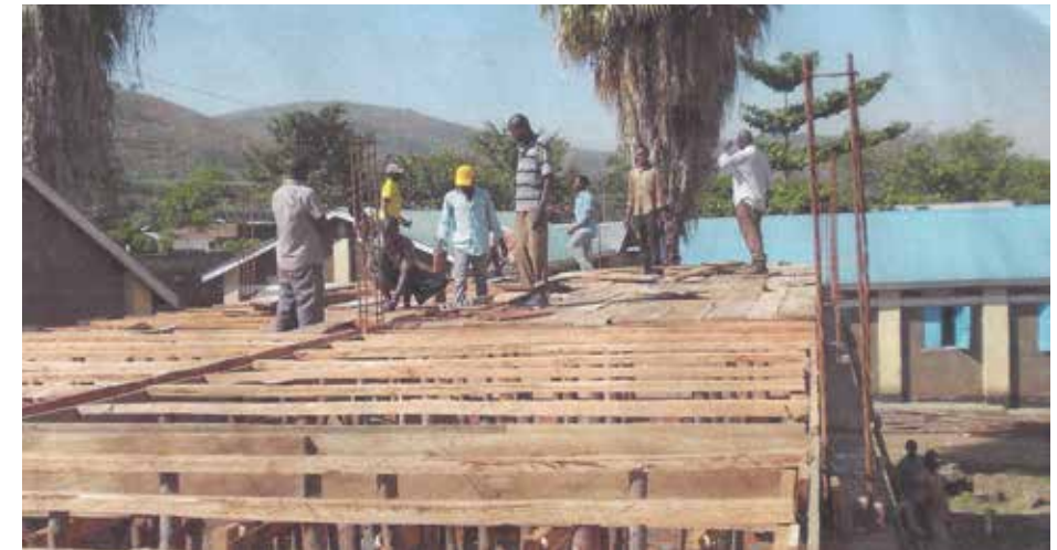
Bau der Sekundarschule in Butiru
