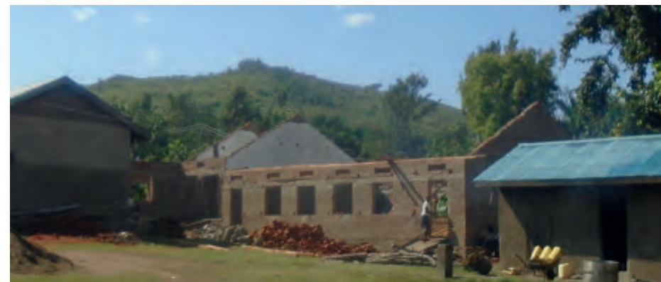
Rohbau eines der Vorlesungsräume des Butiru PTC im November 2016
